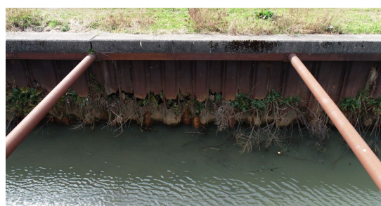
図2 既設軽量鋼矢板の孔食
